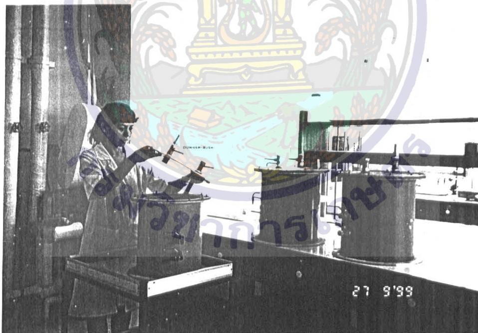
ภาพที่ 3 ลักษณะของถังหมัก PVC ที่มีความจุ 25 ลิตร
