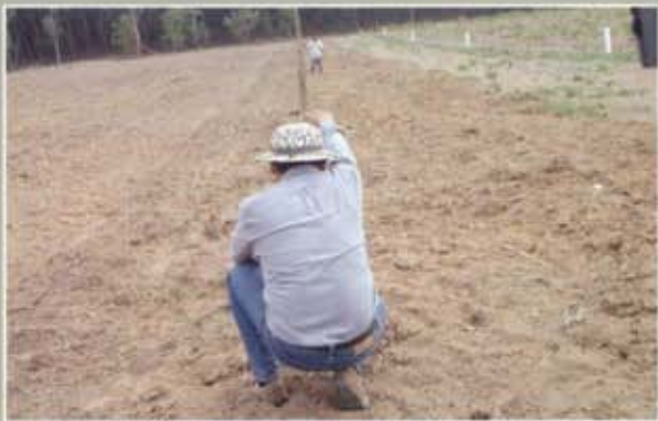
วางแนวปิกระบบ
